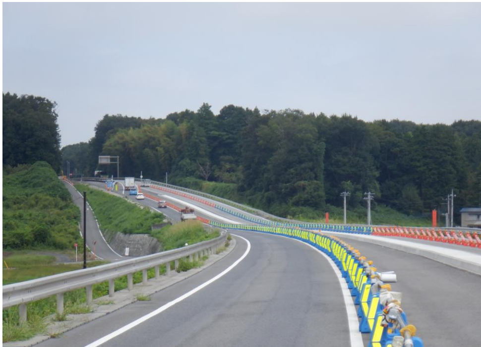
国道408号宇都宮高根沢バイパス
