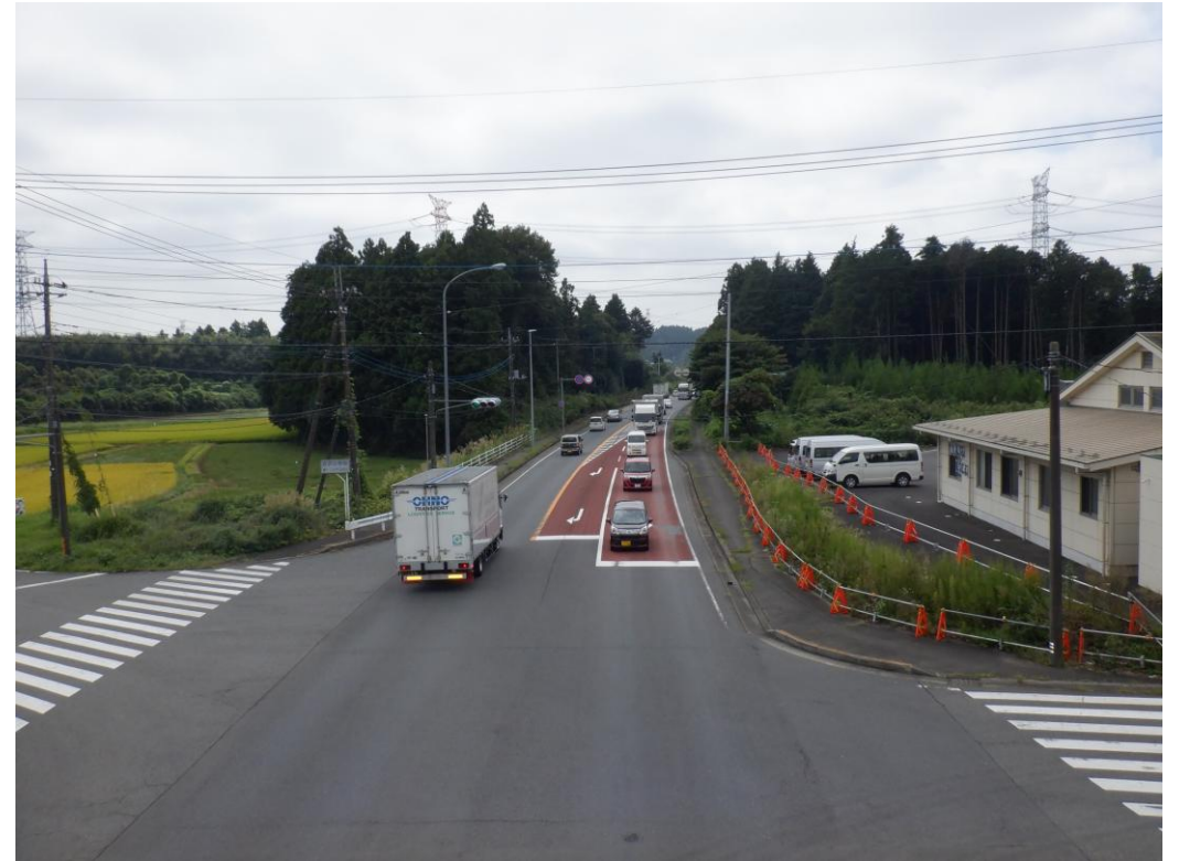
国道4号矢板拡幅
