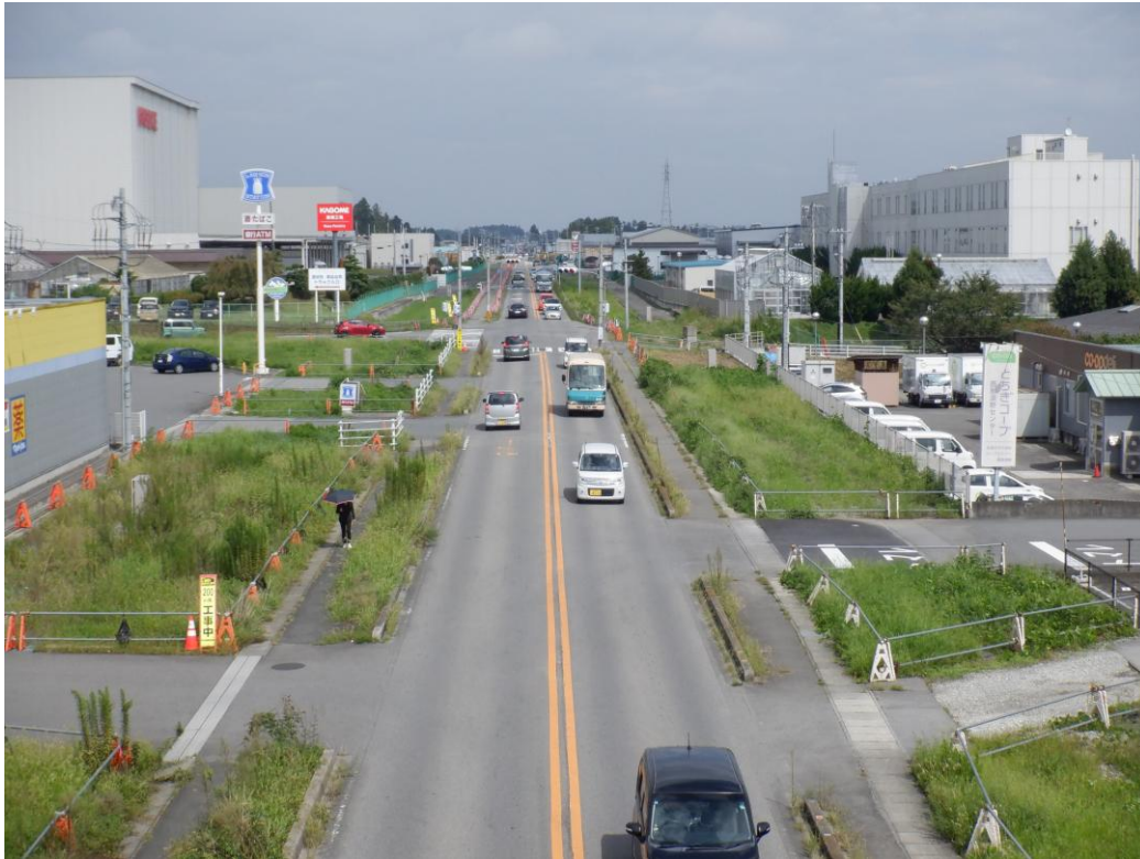
国道4号西那須野道路
