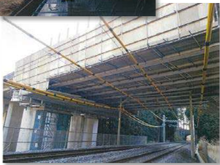
日光宇都宮道路 室瀬高架橋 橋梁補修工事
