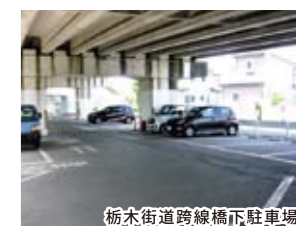
栃木街道跨線橋下駐車場
