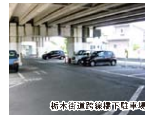
栃木街道跨線橋下駐車場
